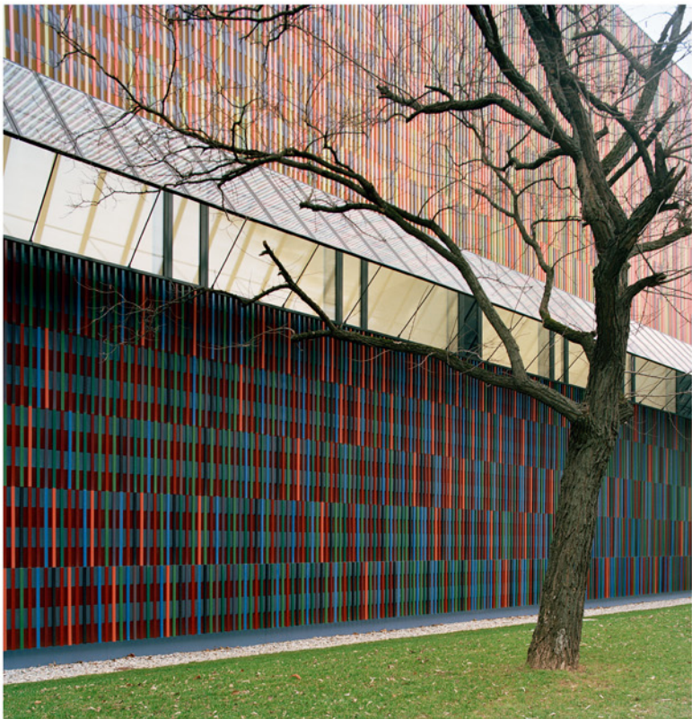
dettaglio esterno dei pannelli che deviano la luce verso l'interno del piano terra exterior detail showing light-deflecting awnings on ground floor
