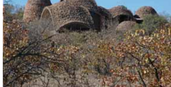
Centro per l'interpretazione di Mapungubwe Mapungubwe (Sudafrica) - Peter Rich Architects con Michael Ramage e John Ochsendorf
