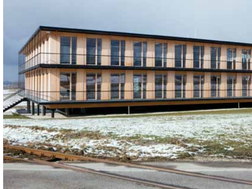
New Building Mayr Melnhof - Kaufmann Administrative Center St. Georgen, Attergau (Austria) - Architekten Hermann Kaufmann ZT GmbH
